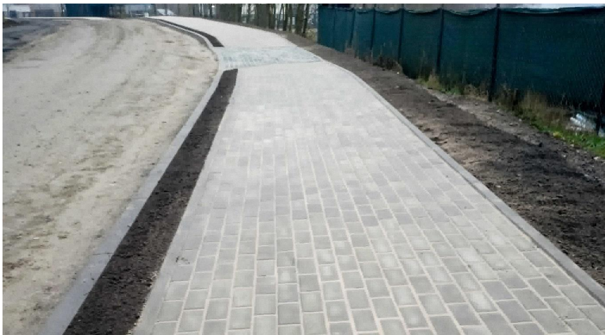
Zdj. 21 Budowa chodnika w Żabinku
