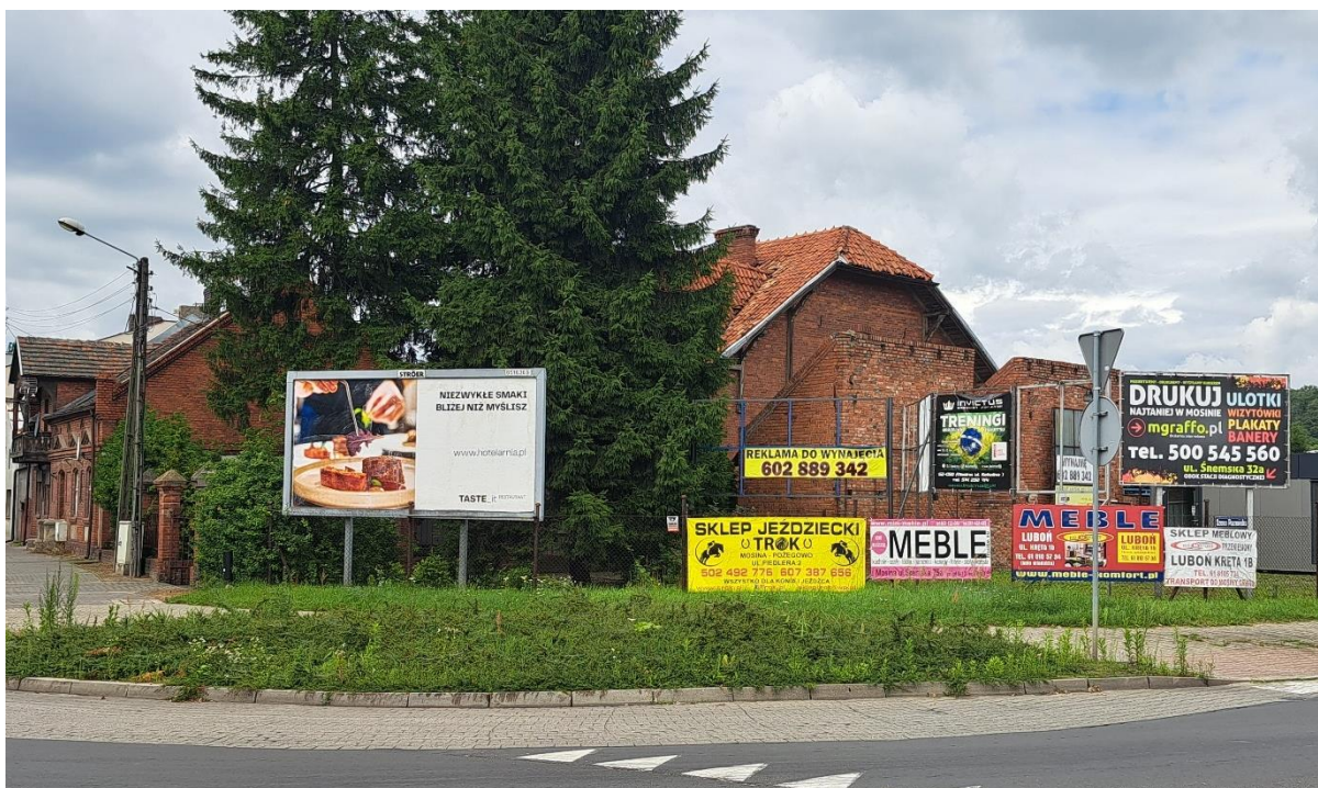
Zdj. 57 Demontaż banerów, reklam - przed
