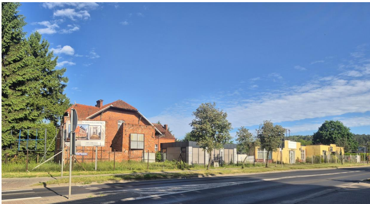
Zdj. 58 Demontaż banerów, reklam - po
