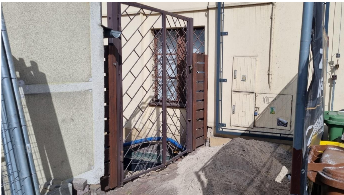
Zdj. 2 Prace modernizacyjne przy Galerii Sztuki w Mosinie
